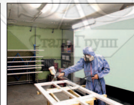
Покраска дверных панелей
